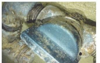
ガス栓や器具栓が劣化すると、すき間からガスが漏れやすくなります。
