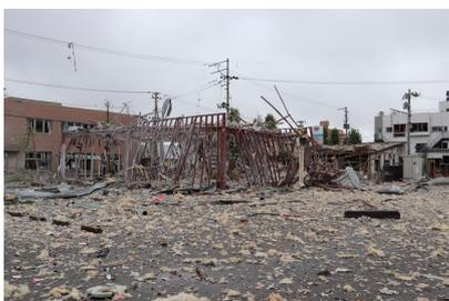
令和2年7月30日に福島県郡山市の飲食店で爆発火災が発生しました。現時点で出火原因等は特定されていませんが、屋内のガス配管の腐食箇所から液化石油ガス（LPガス）が漏洩し、引火、爆発した可能性が考えられます。類似事故の発生を防止するため、ガス機器の適切な維持管理を徹底してください！
