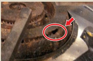
ガスバーナーの炎孔が腐食して、穴が繋がっています。
