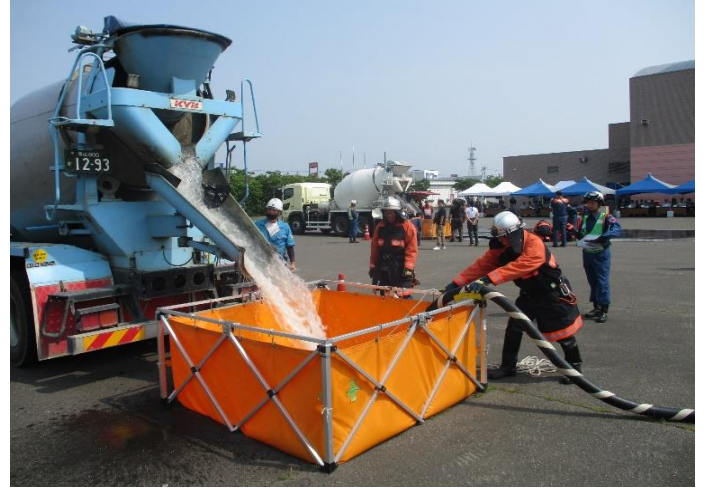
車両後方の簡易水槽へ給水
