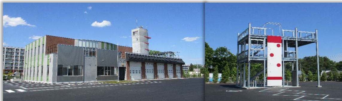
【帯広消防署 柏林台出張所 令和2年7月移転新築（2出張所統合）】
